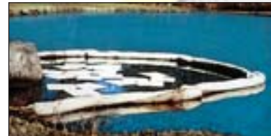
Absorptionsmaterial für Kohlenwasserstoffe (Öl, Diesel usw.). Das Material treibt auf dem Wasser und nimmt alle Verunreinigungen auf.
