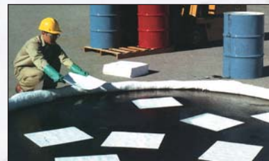
Schläuche dämmen die Leckage ein, Matten nehmen die Flüssigkeit auf.
